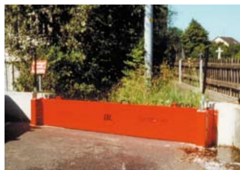
▲ Barrière manuelle. Serrage manuel par verin aux extrémités.
