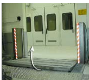
Barrières anti-pollution Rétention Eaux d'incendie
