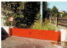
3 Barrière manuelle. Serrage manuel par verin aux extrémités.
