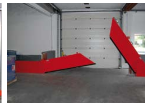
▲ Barrière électro-pneumatique (connection sur alarme...).
